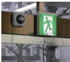
同軸ケーブルの配線が難しい場所に監視カメラを取り付ける場合、配線の取り回しが複雑になり、また外観も損ねる要因となります。PV500C-BNなら、ネジで取り付けるだけ。同軸ケーブル配線も必要なく、柔軟に取付位置を決定することが出来ます。録画もカメラ自体のSDカードに記録するため、別途録画機の用意は必要ありません。ドームカバー部分は強化ポリカーボネートカバーによる堅牢設計。ハンマーで叩いても壊れません。
