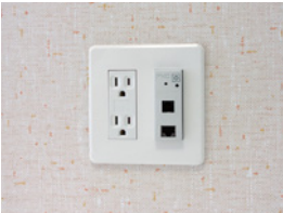
* 2 ロプレートに取付けた状態
